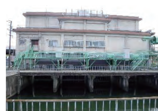
洲崎排水機場
